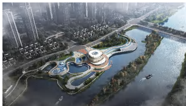
中马钦州产业园金鼓江岸线综合生态整治修复工程
