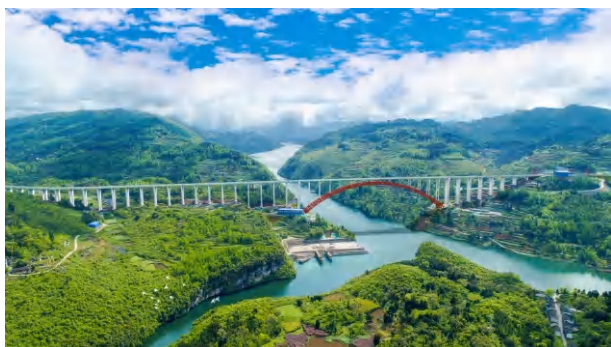
德余乌江特大桥
